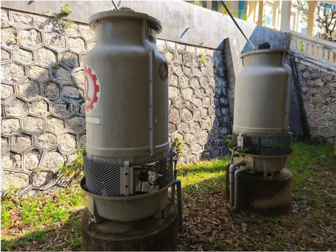
Hình: THÁP GIẢI NHIỆT CHO HT LẠNH CÔNG NGHIỆP
